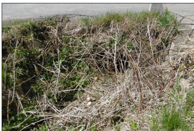
Propustek 20c - staničení 0,001 - pohled zprava
