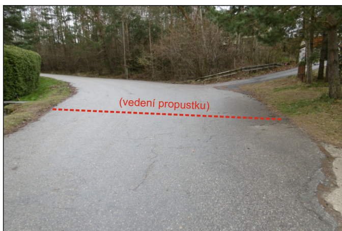
Propustek 1c - staničení 1,055 - pohled zprava
