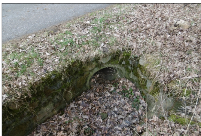
Propustek 14c - staničení 1,656 - pohled zprava
