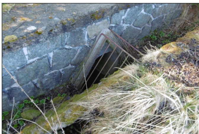
Propustek 2c - staničení 1,467 - pohled zprava
