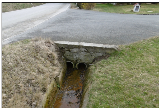
Propustek 13c - staničení 0,002 - pohled zprava
