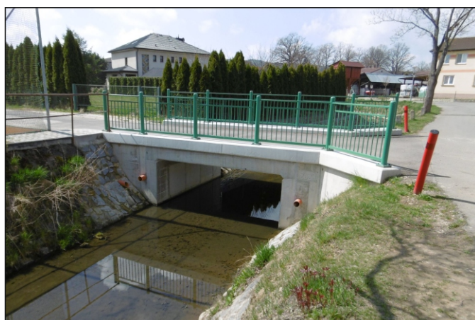
Most 16c-M1 - staničení 0,152 - pohled zprava
