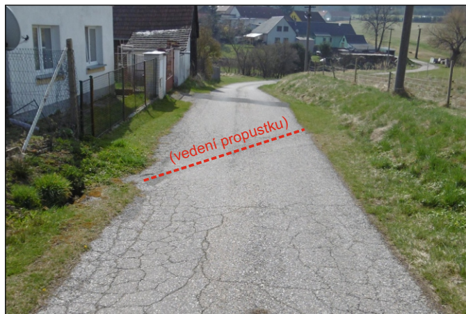
Propustek 1c - staničení 1,315 - pohled zprava
