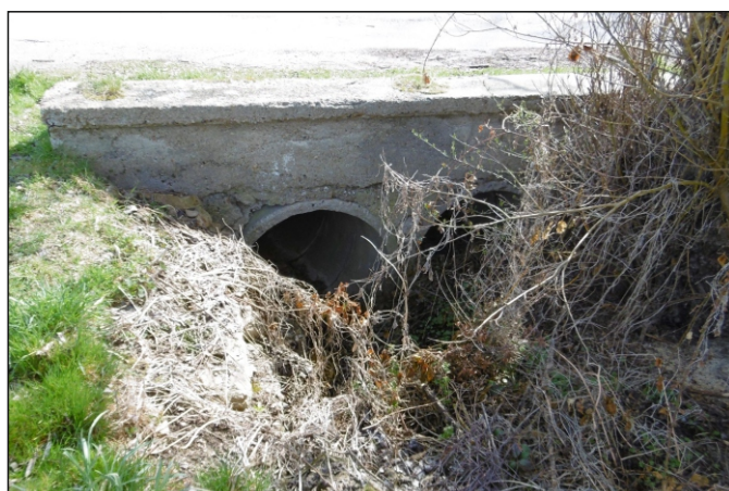
Propustek 26c - staničení 0,732 - pohled zleva
