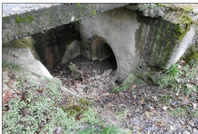
Propustek 1c - staničení 1,055 - pohled zprava
