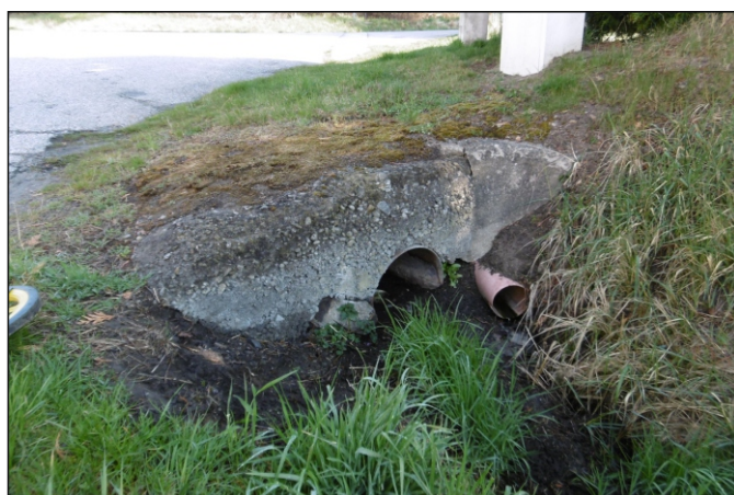
Propustek 2c - staničení 1,467 - pohled zprava
