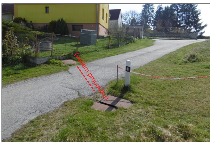
Propustek 26c - staničení 0,240 - pohled zprava
