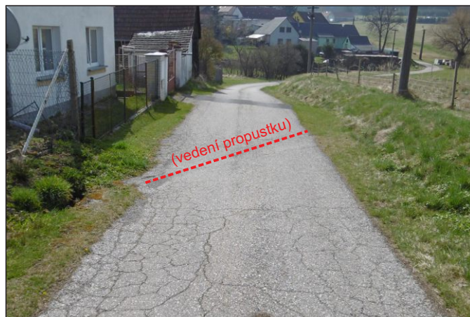
Propustek 26c - staničení 0,069 - pohled zprava
