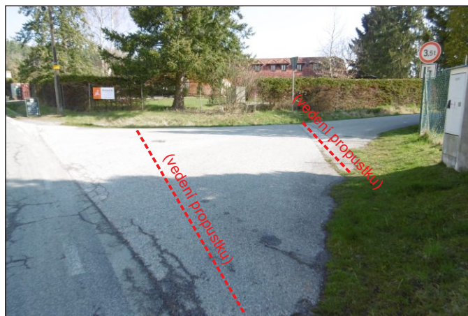
Propustek 25c - staničení 0,002 + 0,007 - celkový pohled
