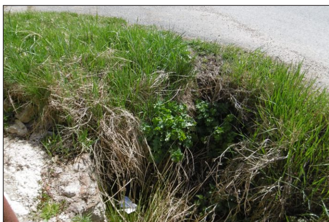
Propustek 20c - staničení 0,001 - pohled zleva
