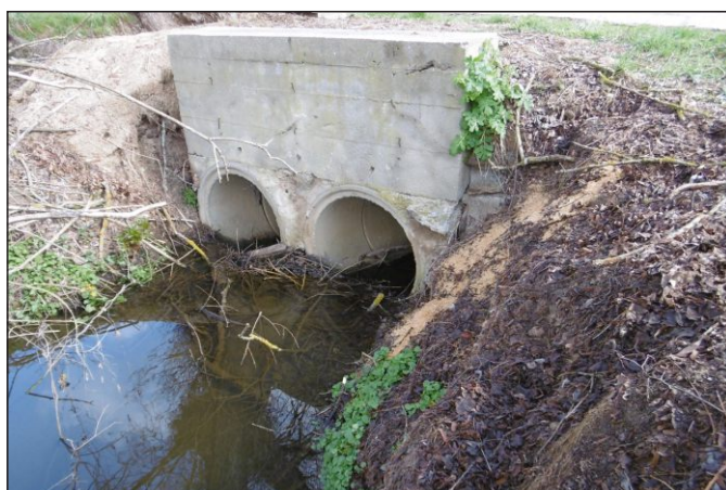
Propustek 26c - staničení 0,193 - pohled zprava
