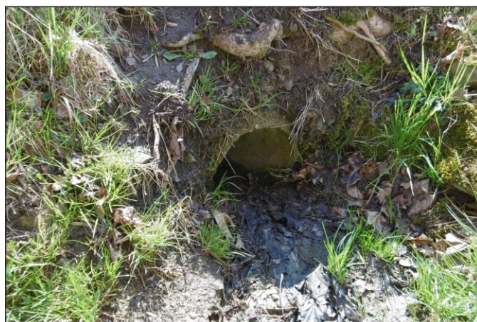
Propustek 15c - staničení 0,151 - pohled zprava
