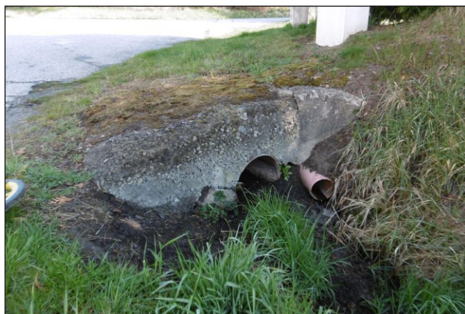
Propustek 25c - staničení 0,002 - pohled zprava
