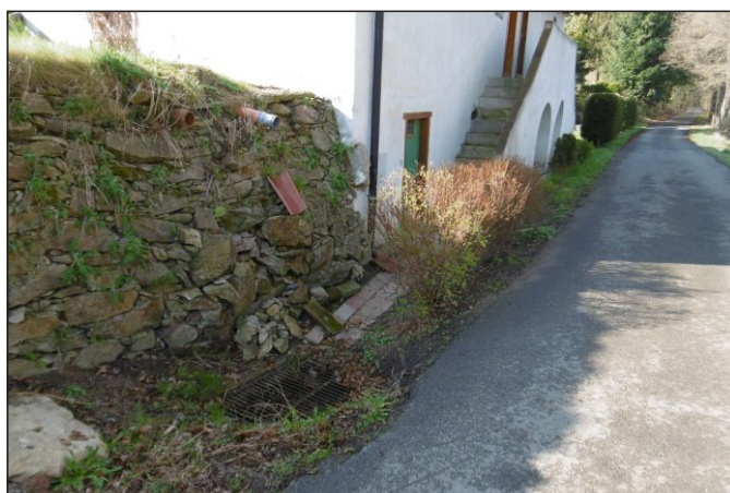
Propustek 21c - staničení 0,735 - pohled zprava
