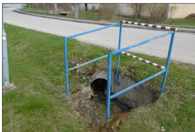
Propustek 2b - staničení 1,600 - pohled zprava
