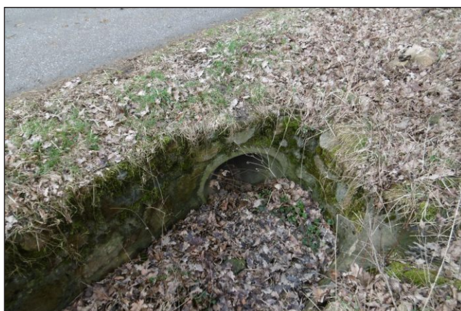
Propustek 14c - staničení 1,656 - pohled zprava
