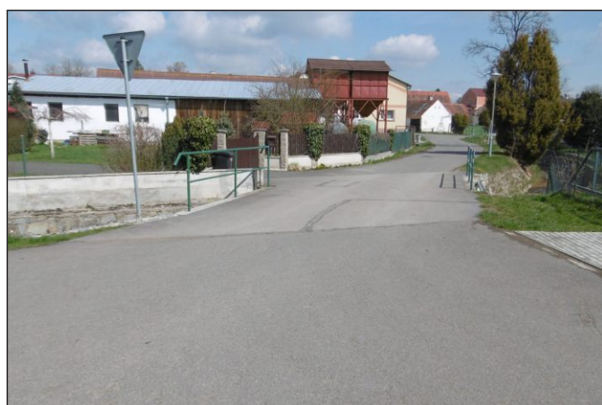
Most 15c-M1 - staničení 0,184 - celkový pohled
