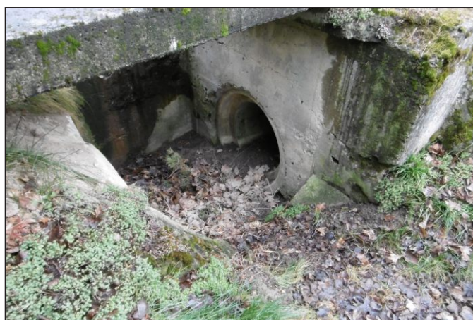
Propustek 1c - staničení 1,069 - pohled zprava
