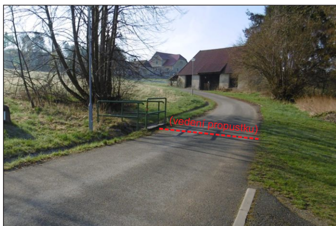
Propustek 21c - staničení 0,232 - celkový pohled
