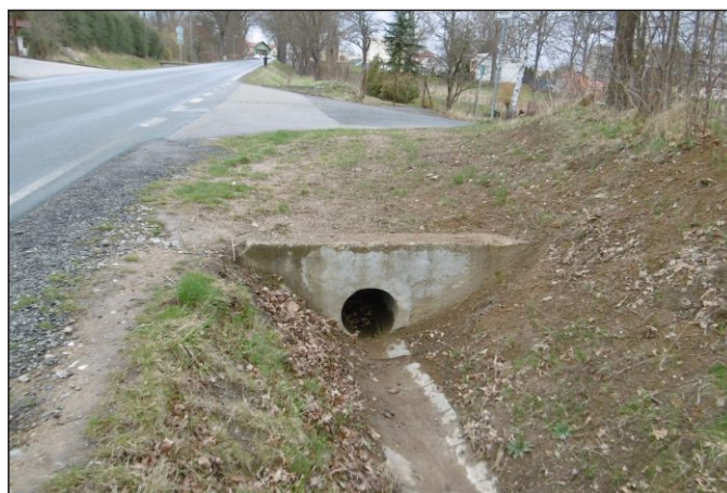
Propustek 3c - staničení 0,003 - pohled zprava
