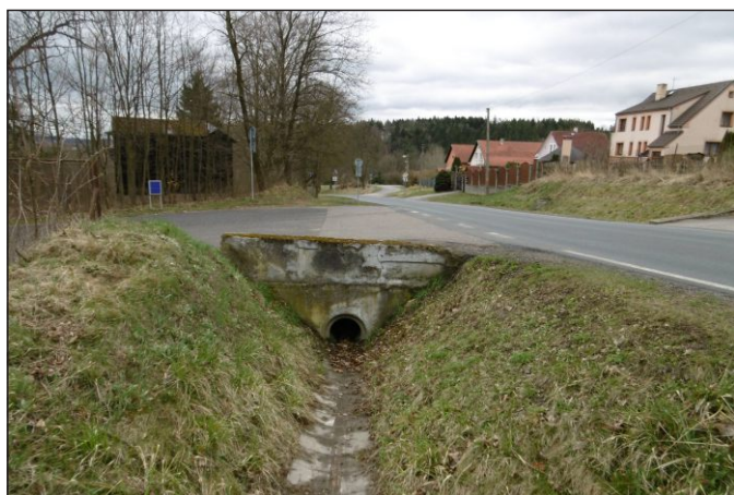
Propustek 3c - staničení 0,003 - pohled zleva
