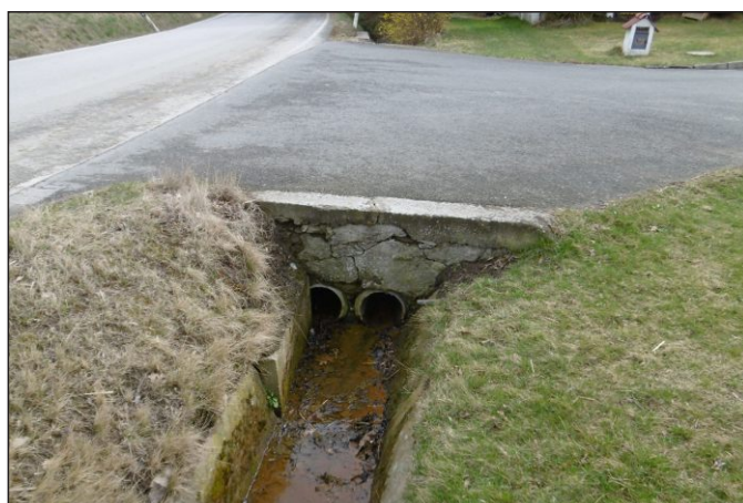
Propustek 13c - staničení 0,002 - pohled zprava
