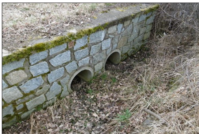
Přepad z rybníka 14c - staničení 1,348 - pohled zleva
