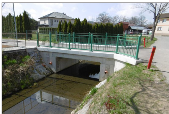
Most 16c-M1 - staničení 0,157 - pohled zprava
