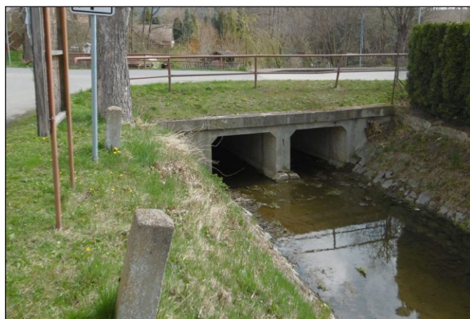
Propustek 2b - staničení 1,456 - pohled zprava
