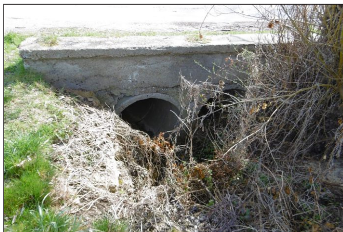
Propustek 26c - staničení 0,191 - pohled zprava
