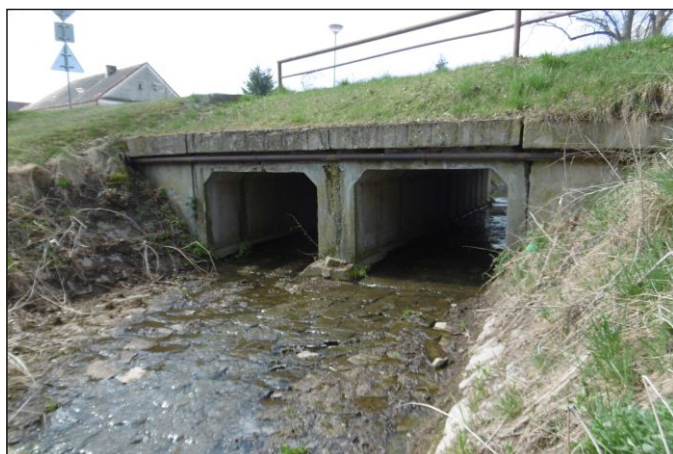
Propustek 2b - staničení 1,456 - pohled zleva
