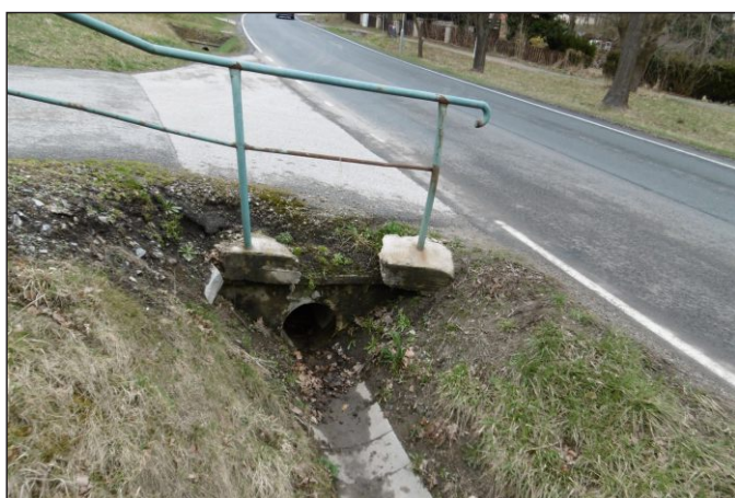
Propustek 8c - staničení 0,002 - pohled zleva
