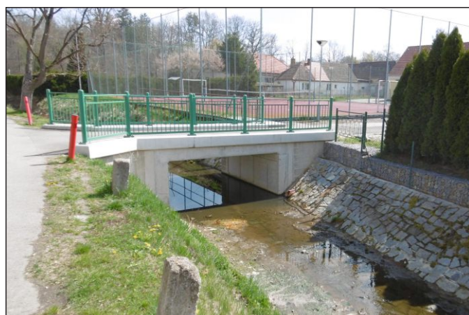
Most 16c-M1 - staničení 0,157 - pohled zleva
