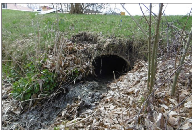
Propustek 2b - staničení 1,600 - pohled zleva
