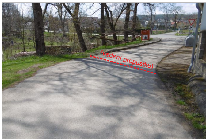
Propustek 18c - staničení 0,029 - celkový pohled
