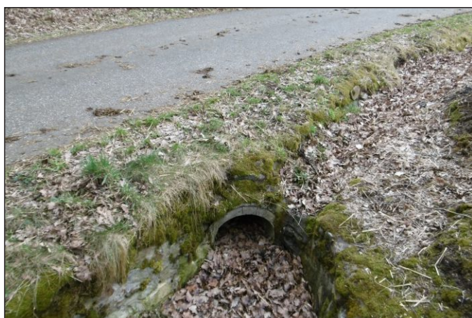
Propustek 14c - staničení 1,656 - pohled zleva
