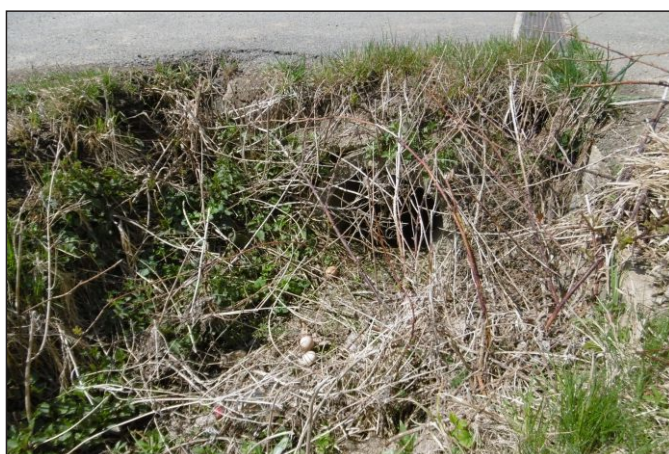
Propustek 20c - staničení 0,001 - pohled zprava
