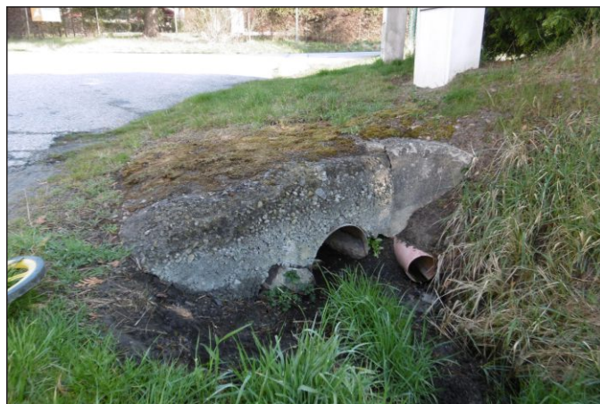
Propustek 25c - staničení 0,007 - pohled zprava
