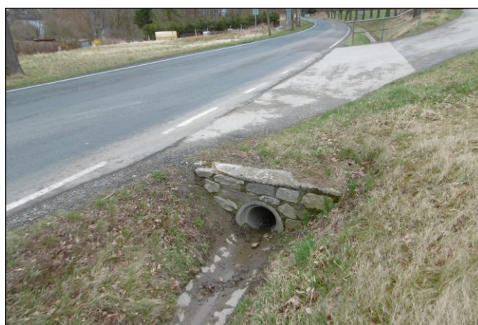
Propustek 8c - staničení 0,002 - pohled zprava
