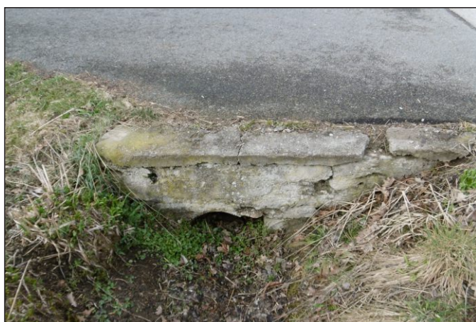
Propustek 13c - staničení 0,002 - pohled zleva
