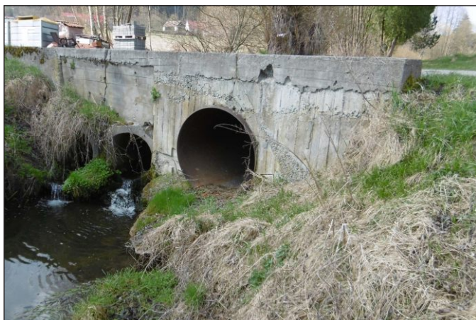
Propustek 26c - staničení 0,191 - pohled zleva
