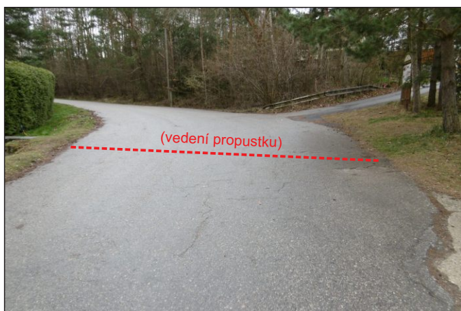
Propustek 1c - staničení 1,069 - pohled zprava
