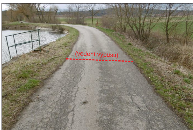
Výpust z rybníka 14c - staničení 1,382 - celkový pohled
