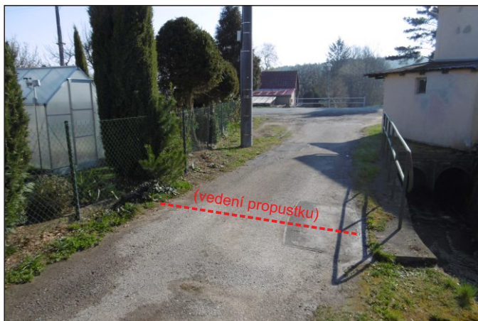
Propustek 22c - staničení 0,023 - celkový pohled
