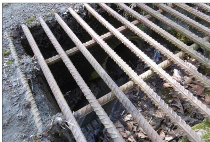
Propustek 18c - staničení 0,029 - pohled zleva
