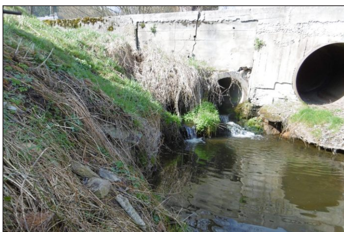
Propustek 26c - staničení 0,193 - pohled zleva
