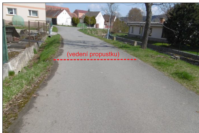
Propustek 15c - staničení 0,151 - celkový pohled
