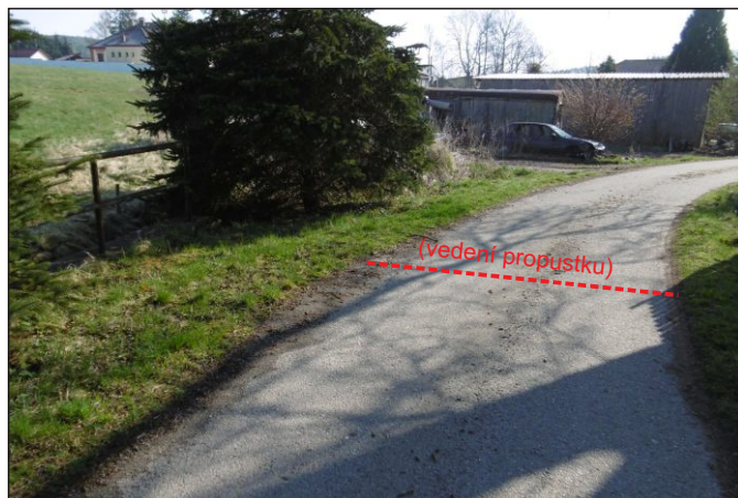
Propustek 23c - staničení 0,108 - celkový pohled
