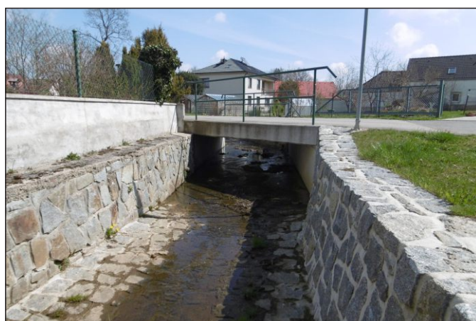
Most 15c-M1 - staničení 0,184 - pohled zprava
